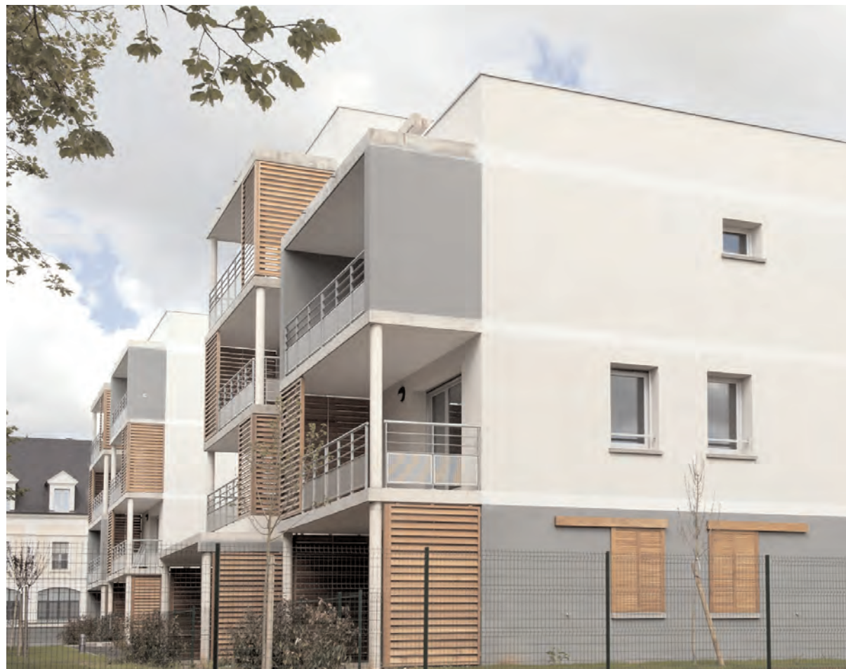
Rue Maryse Bastié, construction de J. Gabriel
