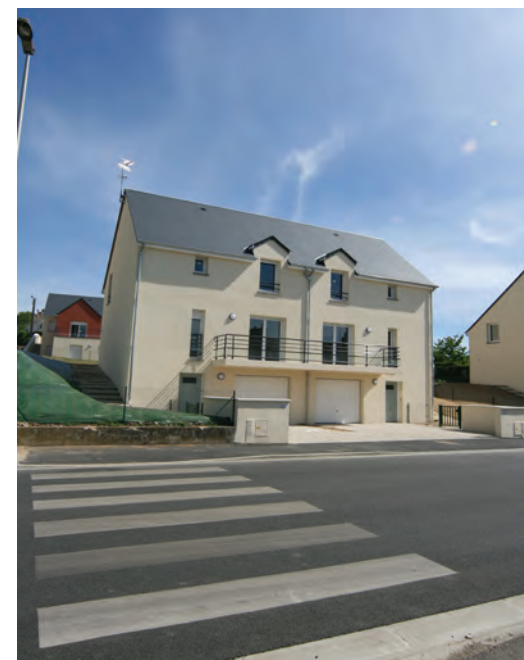
Rue Michel Bégon, construction de Terres de Loire Habitat
