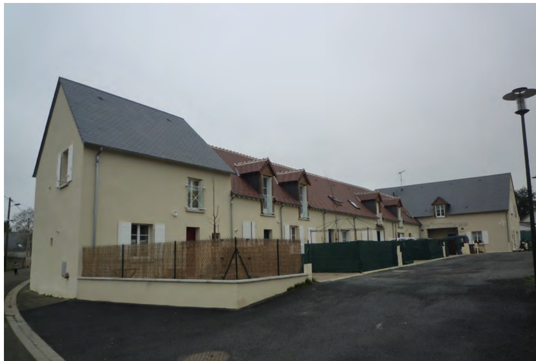
Rue Belin, construction de Loir-et-Cher Logement
