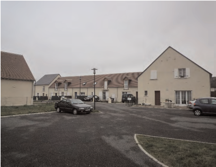
Rue Belin, construction de Loir-et-Cher Logement.
