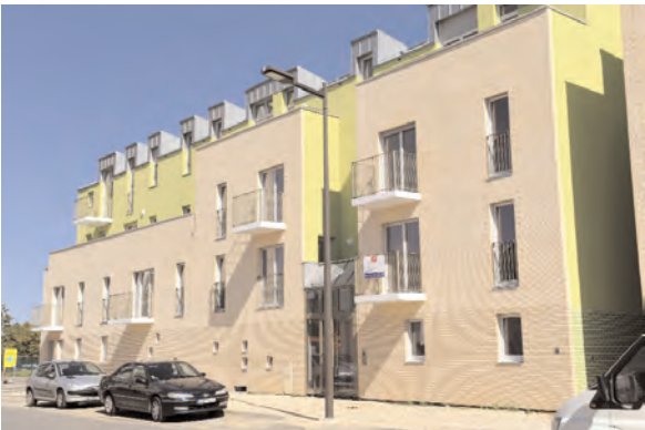
Rue Jean Bart, construction de J. Gabriel
