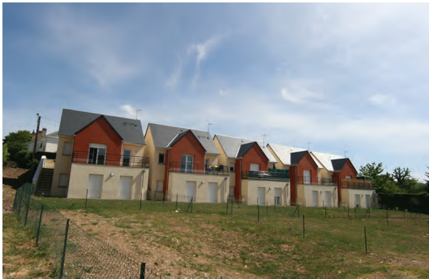
Chemin de Landes, construction de Terres de Loire Habitat
