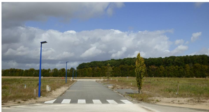
Secteur viabilisé et prêt à bâtir au bout de la rue Paul Bourdier
