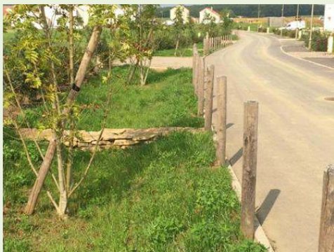
Aménagement de noue paysagère en bordure de desserte
