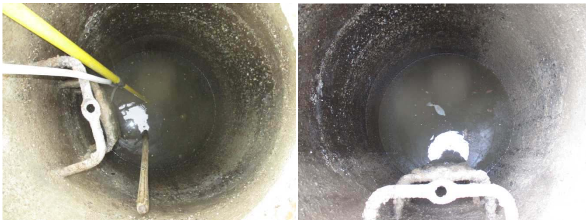
Figure 14 : Regard en charge sur la commune de Fréteval (A gauche : en amont de la STEP. A droite : Devant la Mairie)
