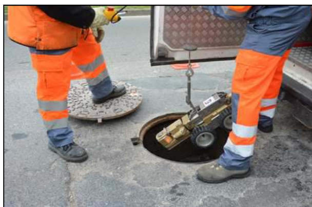
Figure 31 : Principe et matériel utilisé lors des ITV
