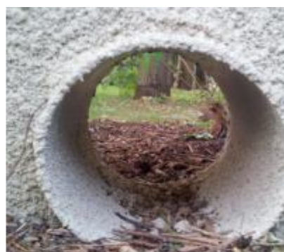
Aménagements d'ouvertures en pied de clôture (avec hérisson décoratif) et de muret
