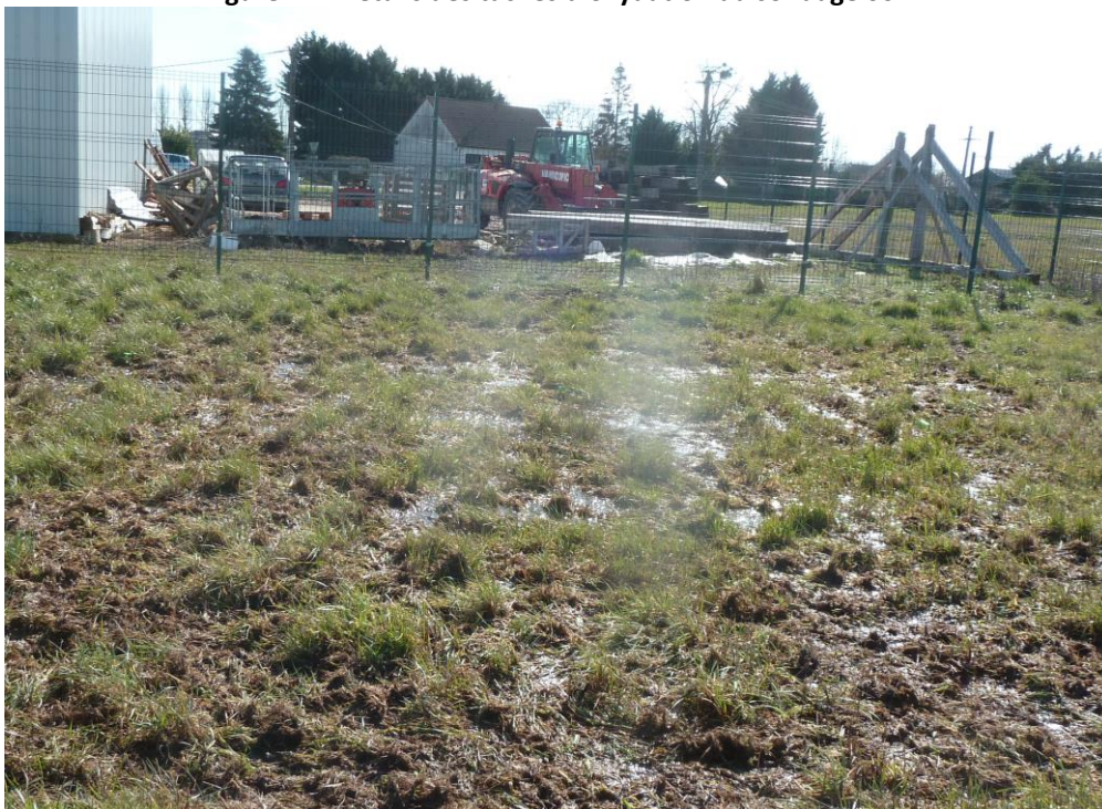
Figure 25 : Stagnation d'eau en surface dans la parcelle
