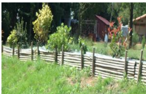
Clôture perméable ou à fascinage pour matérialiser les limites de la parcelle
