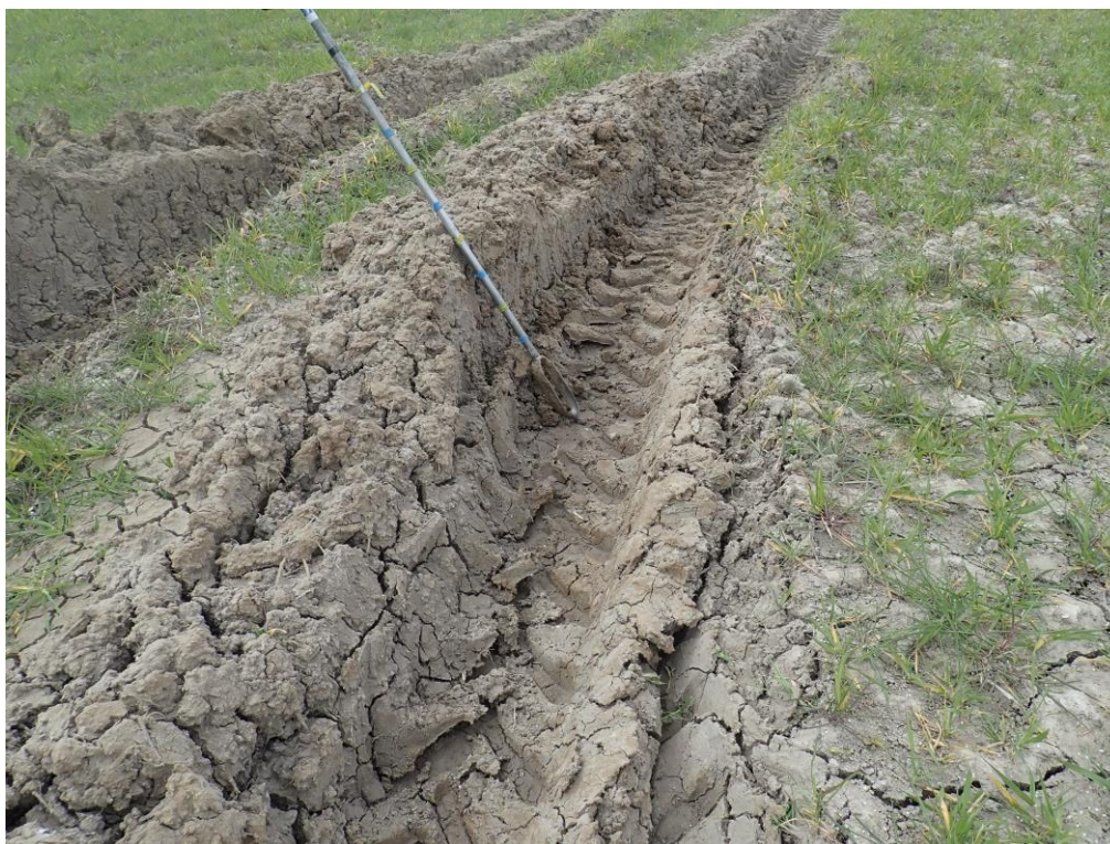
Figure 28 : Ornières de plus de 40 cm de profondeur en bas de parcelle
