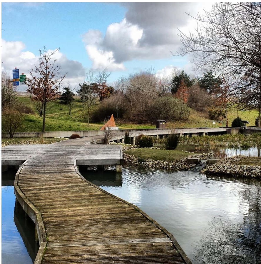
Figure 46 : Création de 7 bassins filtrants pour l'épuration des eaux de la Seine à Nanterre et lieu de promenade (source : Ariel Kogan – SNPN)
