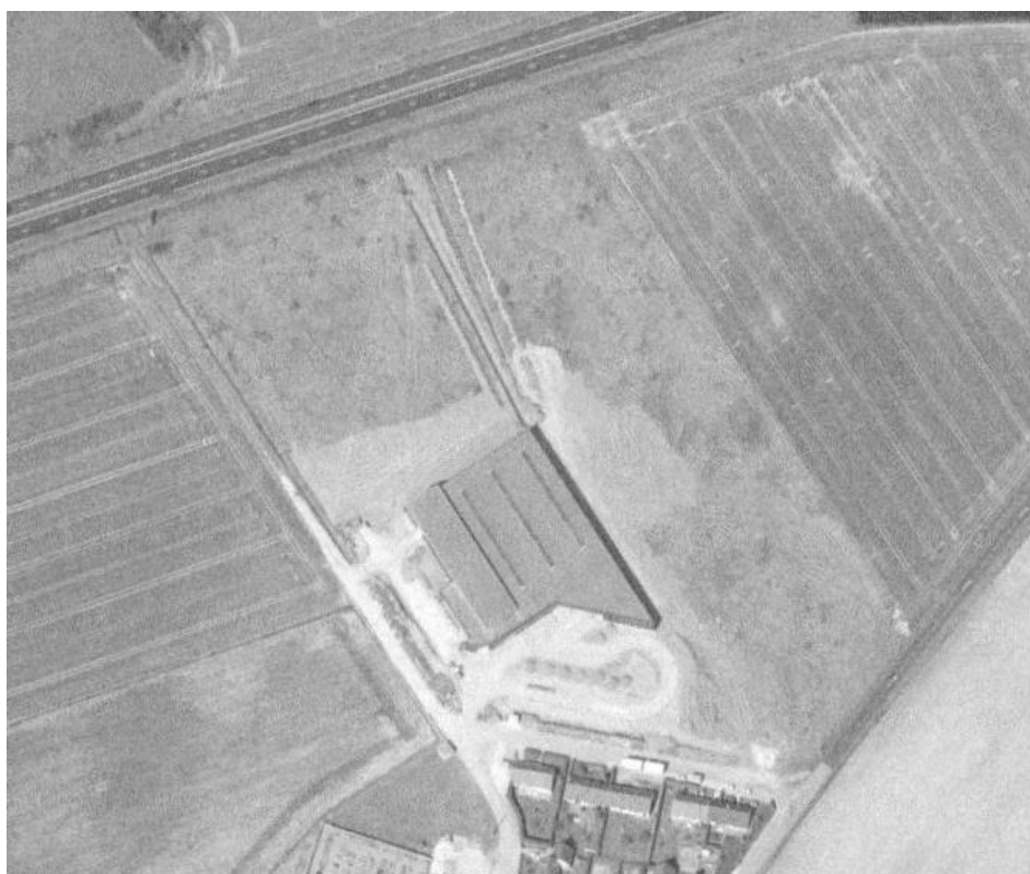
Figure 33 : Vue aérienne du site industriel TIAC en 1996, année de création (source : www.remonterletemps.ign.fr , identifiant : C96SAA0541_1996_F2021_0066)
