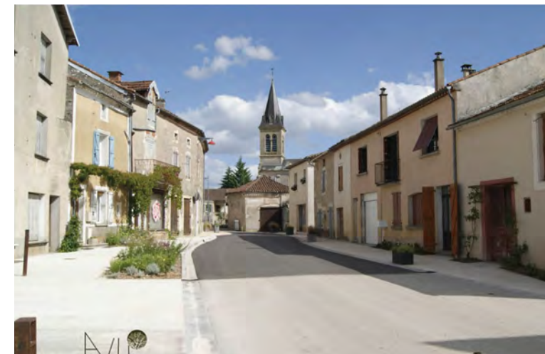
Sécurisation d'une traversée en centre-bourg avec aménagement d'espaces piétonniers
