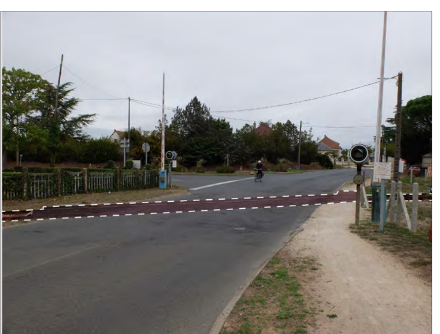
passage de la voie ferrée : une traversée piétonne peu sécurisée
