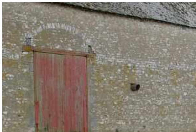
Détail de la façade beauceronne, dont l'aspect texturé est donné par les moellons calcaires jointoyés à pierre vue
