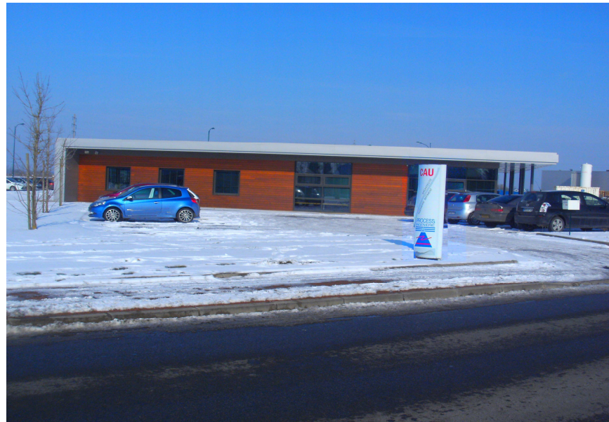
Le siège social de l'entreprise Cabinet d'Architecture et d'Urbanisme.
