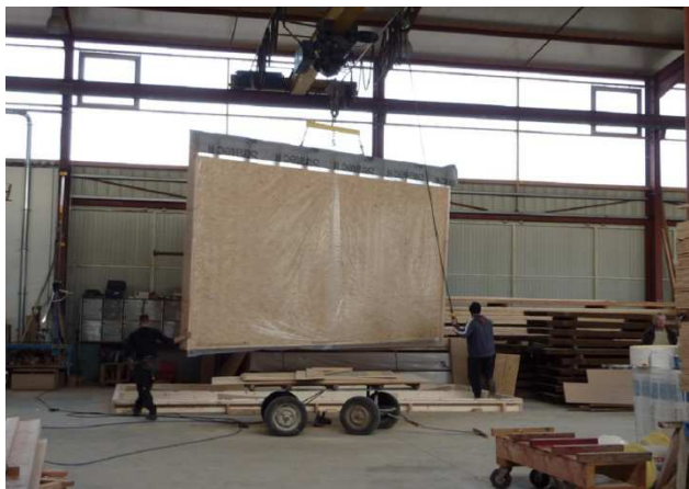
Déplacement sur pont roulant d'un panneau en bois
